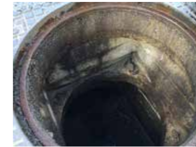
Sisäänkäynti hulevesiverkkoon 3 vuoden käyttöänsä jälkeen. Ei näkyvää vauriota.
