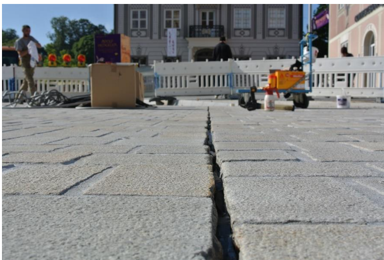
Ulkobetonilaatan sauma / jalankulkualue
