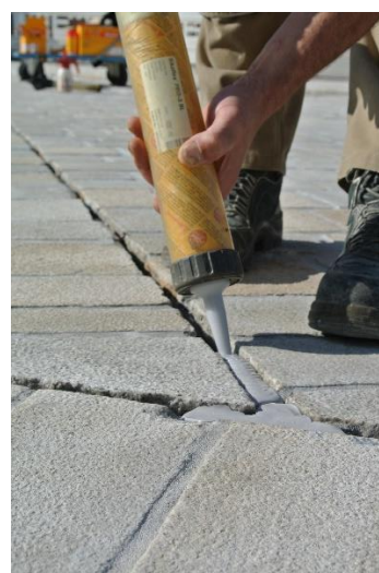
Betonilaatan saumausmassan asennus
