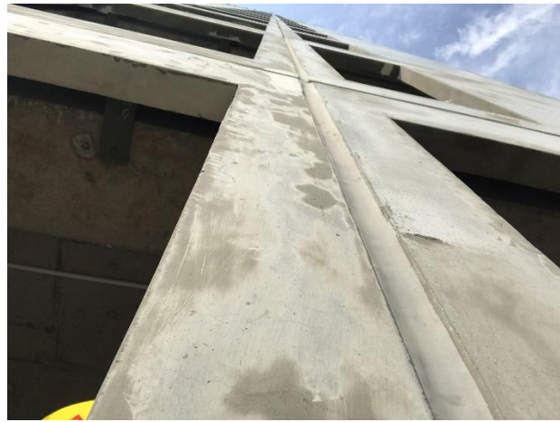
Betonielementin liikuntasäuma
