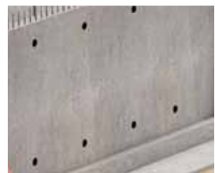
SikaDur® 31 Muotin sidetangon läpivien- nin tiivistys
