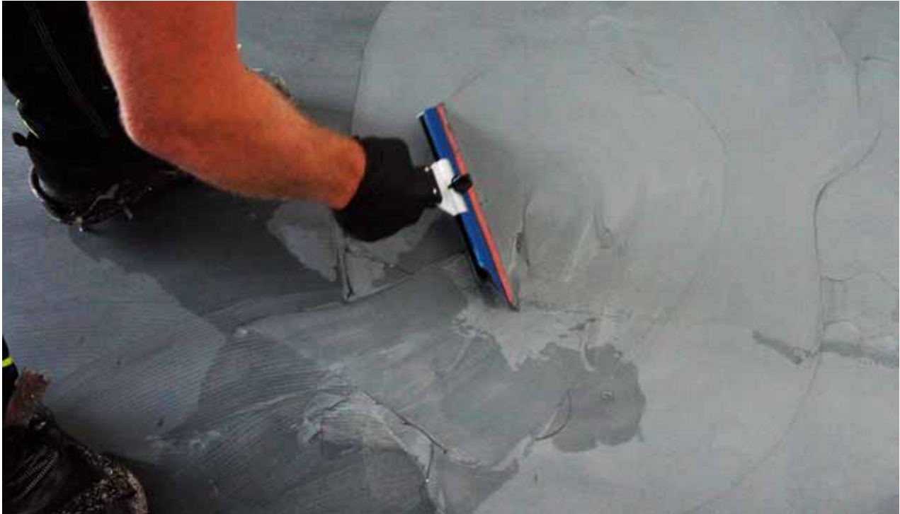
Sikafloor®-3000 FX levitetään lattiapintaan ja kuvioidaan käyttäen erilaisia työvälineitä. Lattia saa uniikin kuvioinnin työvälineestä riippuen.
