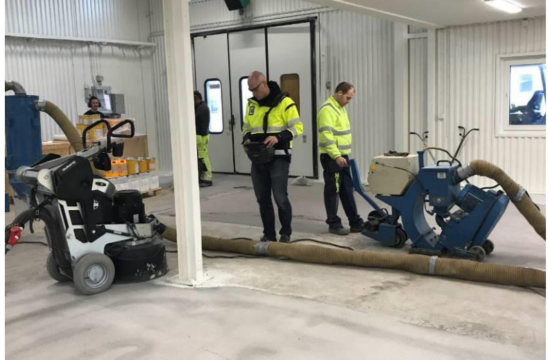
Alustanesikäsitely: Sinkopuhallus tai muu vastaava mekaaninen tarkoittaa. esim. Blastrac, HTC
