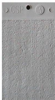
CSP-3: Kevyt sinkopuhallus/ Karhennusvasara
