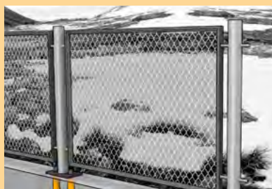
Kaiteiden jälkiasennukset perusmuureihin
