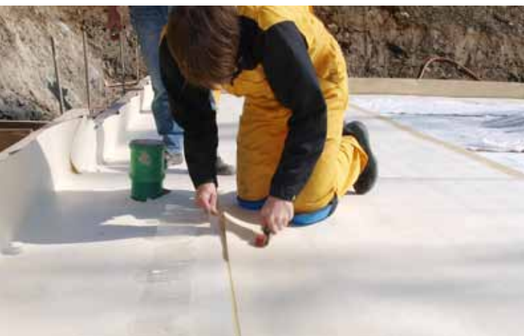
Pitkittäissuunnan saamaaminen itsekiinnittyvää liimapintaa käyttäen
