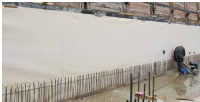
Yksi- tai kaksipuoliset muottirakenteet seinämissä
